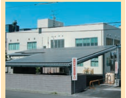
●太陽光発電装置（鹿児島工場）
